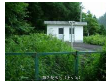
第2配水池(上ヶ洞)
